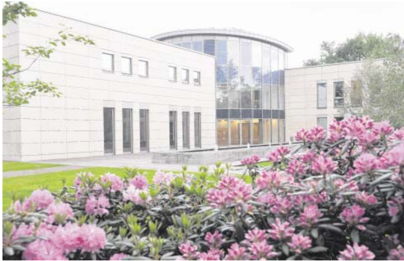
Hinter der Glasfassade erstrecken sich Solarzellen
