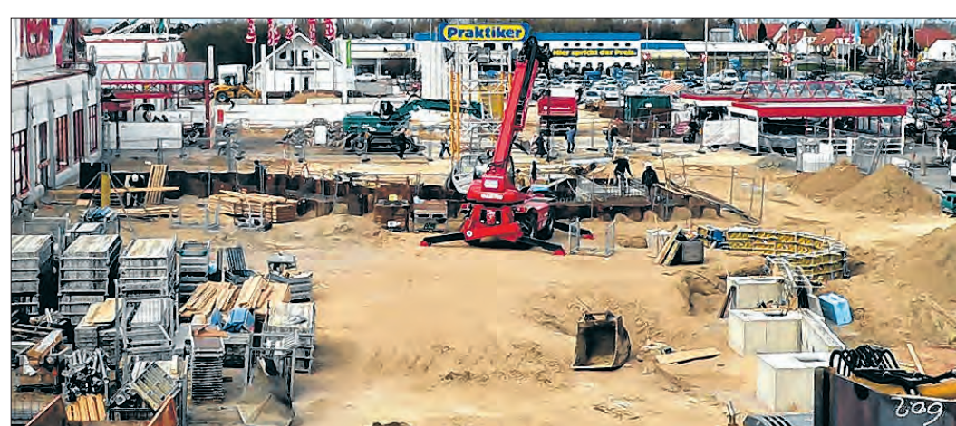
März 2012 - die Bauarbeiten in vollem Gange...
