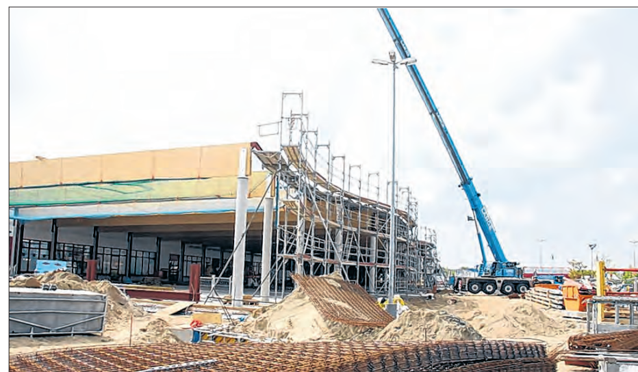
Mai 2012: Der kurvenförmige Grundriss, der an eine Welle erinnert, ist bereits deutlich erkennbar...
