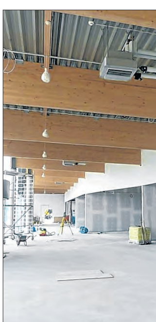
Der neue Anbau von innen. Auch er nimmt langsam Formen an...
